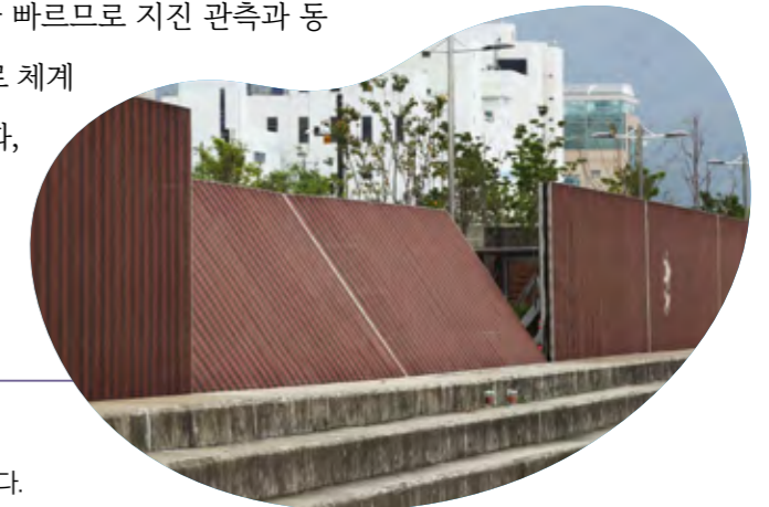
그림 II-21 차수벽 설치 모습 해일을 막기 위해 기립식 방재벽인 차수벽을 설치하고 있다 (경상남도 창원시).
